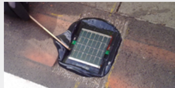
LED-Mark nedfræst i fodgængerovergang og limet
